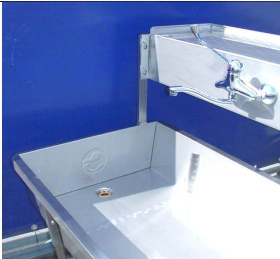
Detail des Beckens und Konsole
