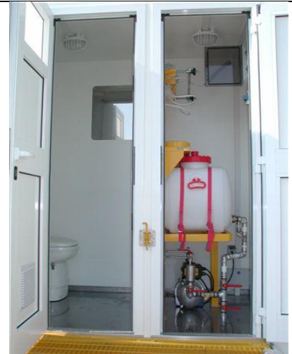
Blick auf die vorderen technischen Räume
