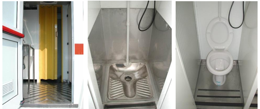
Innendetails: Eingang/Abzweigung - Kabine mit Stehtoilette – Kabine mit „Standard-Becken“
