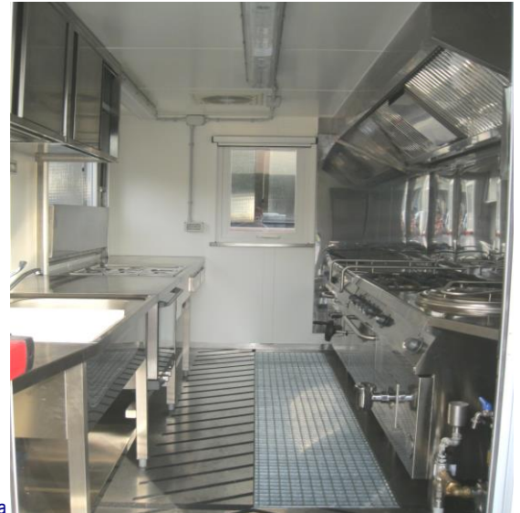
Vista desde entrada/lado distribución
