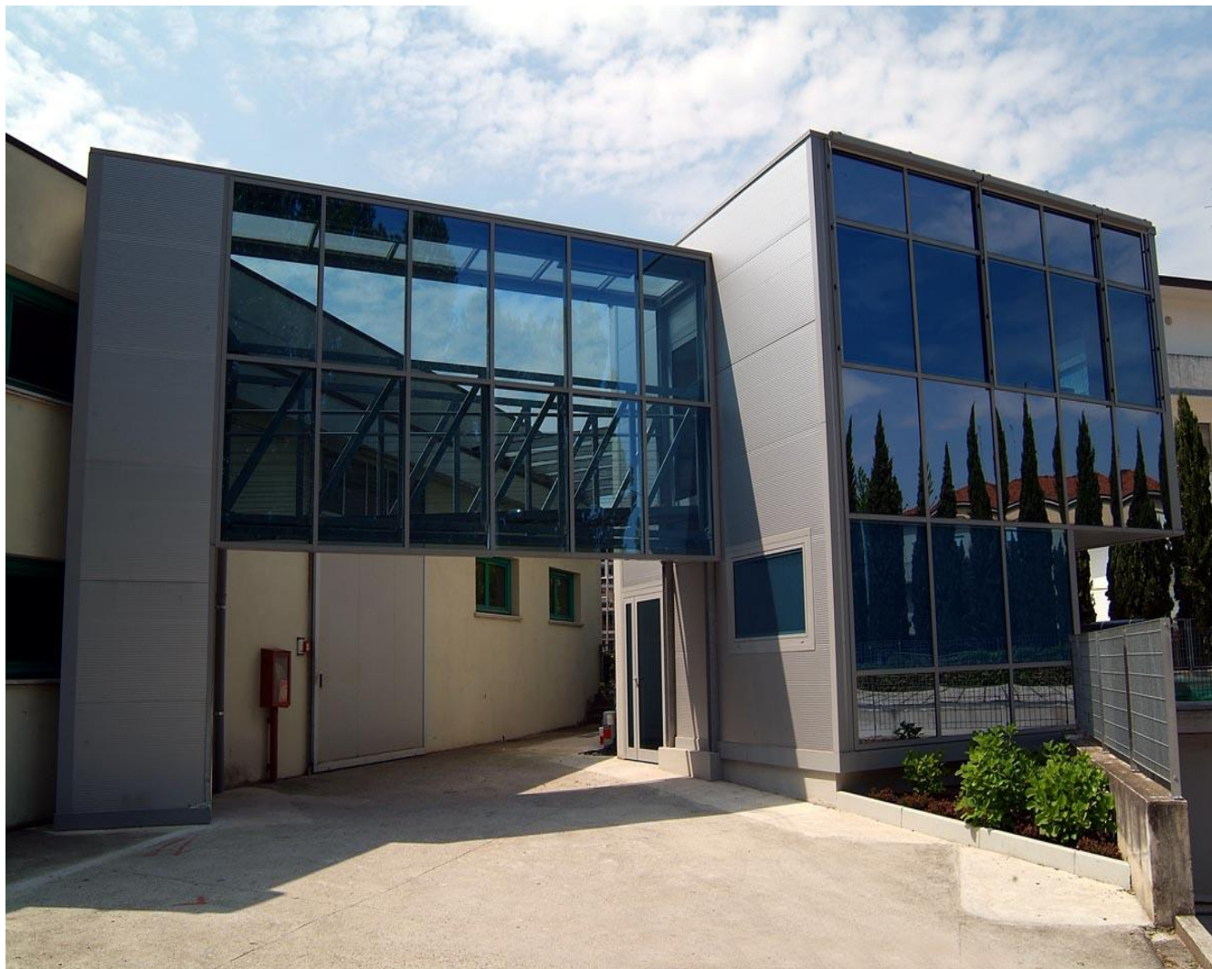
Struttura metallica con Facciata Continua
