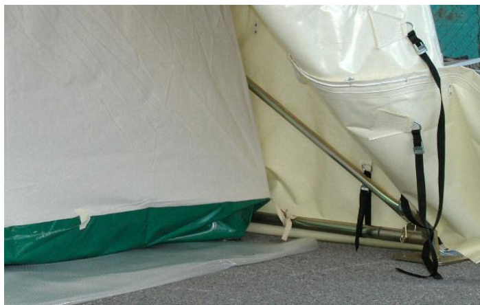
Particolare angolo con vista su struttura, telo esterno e camera con catino
