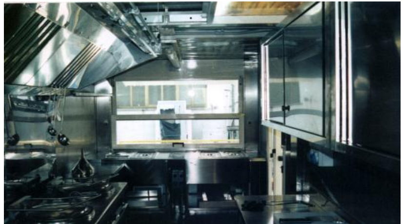
Vista interna del modulo verso l'area distribuzione
